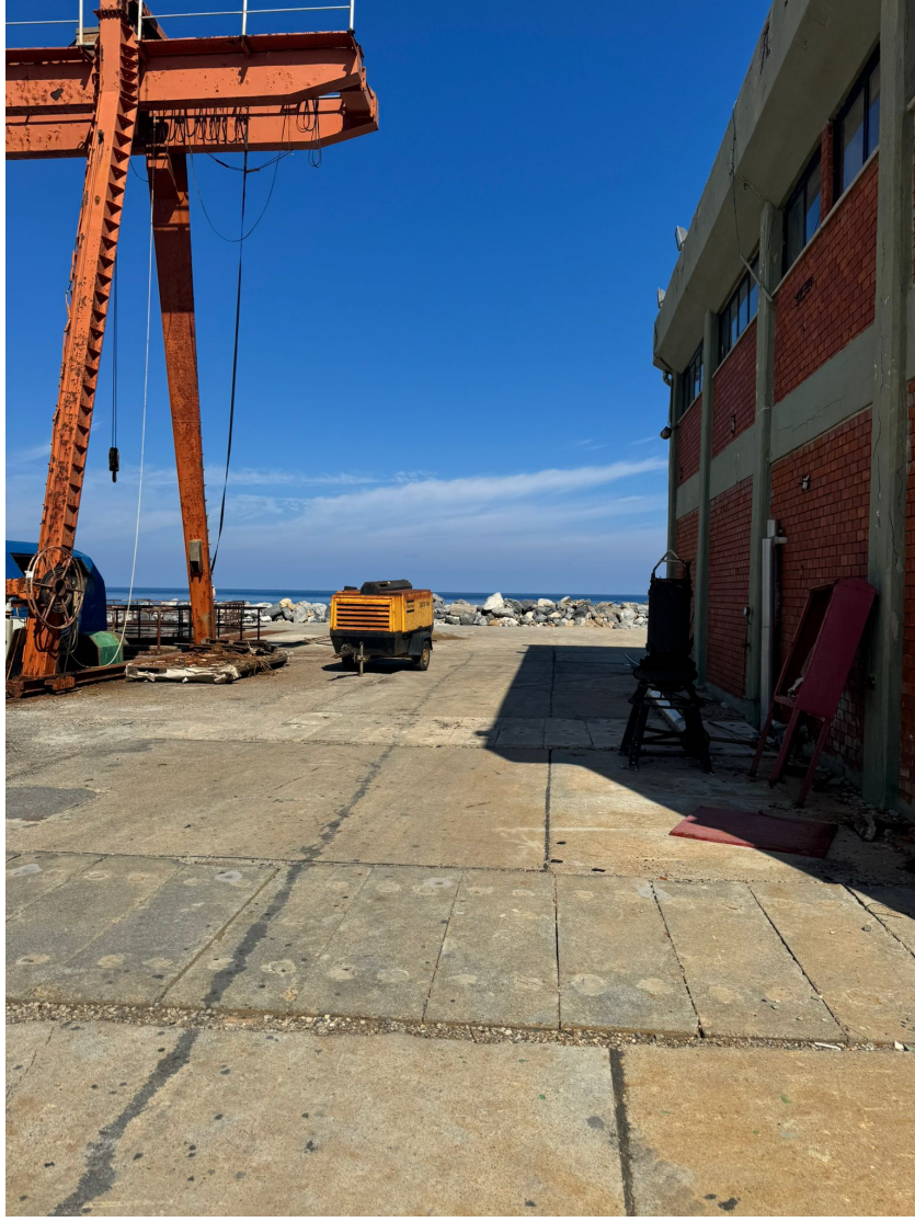
Fotoğraf 11. Klor gazı tanları ve tüplerinin tutulduğu depo (sağ), buhar santralleri için soğutma suyu olarak kullanılan deniz suyu emiş noktası (sol), işlemin gerçekleştirileceği alan denizden taraf orda betonarme zemin
