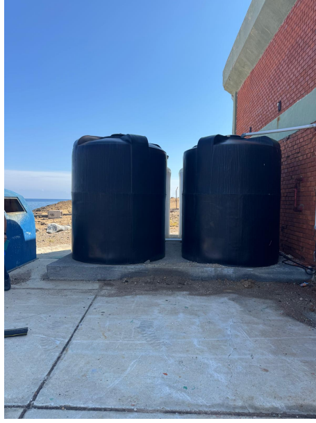
Fotoğraf 8. Tesiste mevcut hipoklorit tankları (işlemin gerçekleştirileceği alanın hemen doğusu tank ve tüplerin tutulduğu deponun bitişiği)
