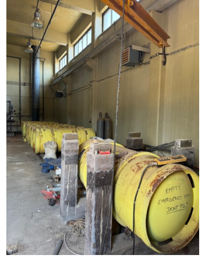
Fotoğraf seti 5,6,7: Depo binası içerisindeki klor gazı tank ve tüpleri
