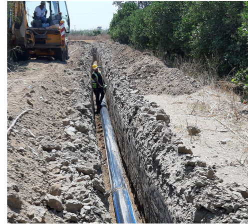
Eski boruların yerini, yukarıda gösterilen yüksek yoğunluklu polietilen su dağıtım boruları aldı
