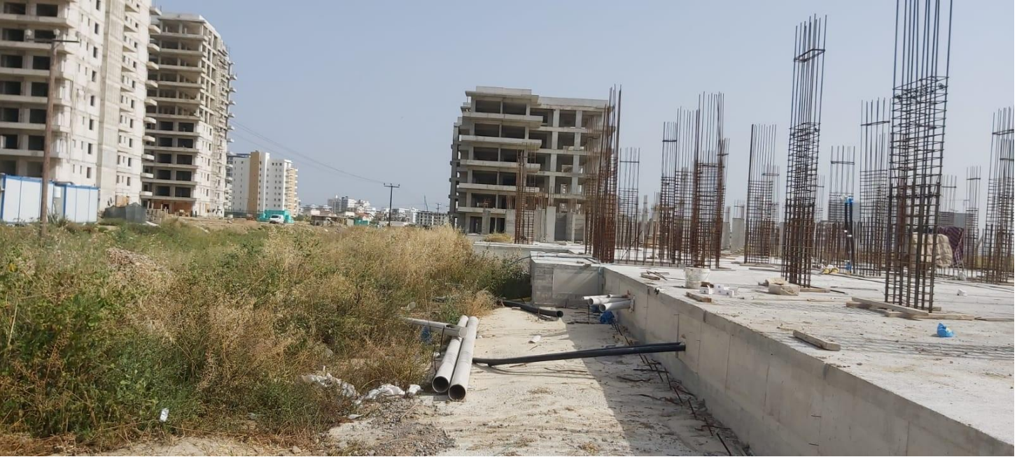
Fotoğraf 4: Proje yeri doğu yönü ( doğu yönünde site 6 inşaatları mevcuttur)
