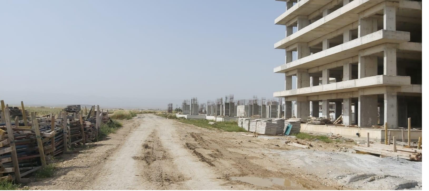
Fotoğraf 3:Proje yeri içerisindeki yarım inşa halindeki konutlar
