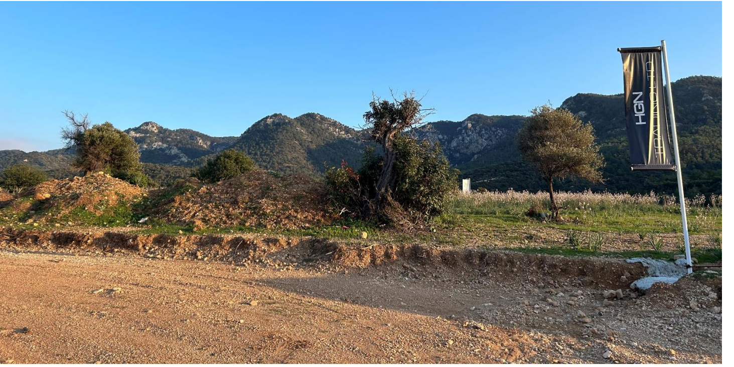
Şekil 9 Proje alanı güneyi (açılan yollar ve toprak yığınları görülmektedir)
