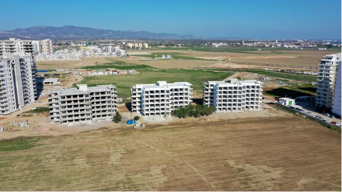
Fotoğraf 3:Proje yeri parsel 71 içerisindeki yarım inşa halindeki konutlar
