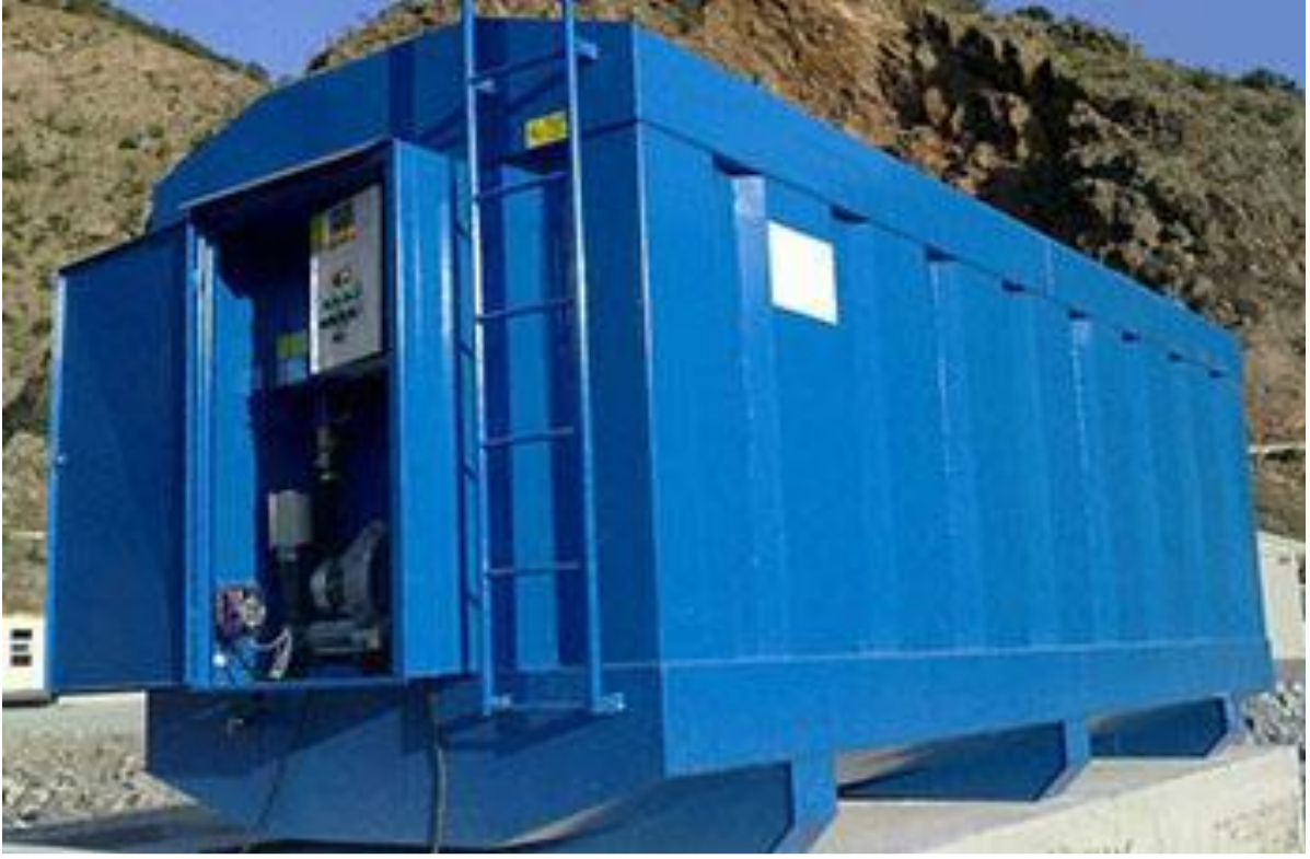
Şekil 18. Membran teknolojisi ile atıksu arıtımı.
