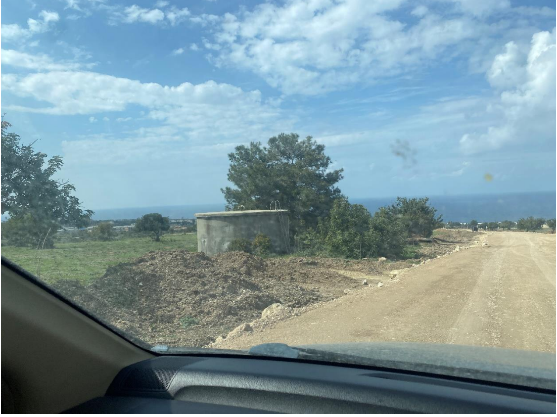
Foto 13 proje alanı içerisinde bulunan su deposu
